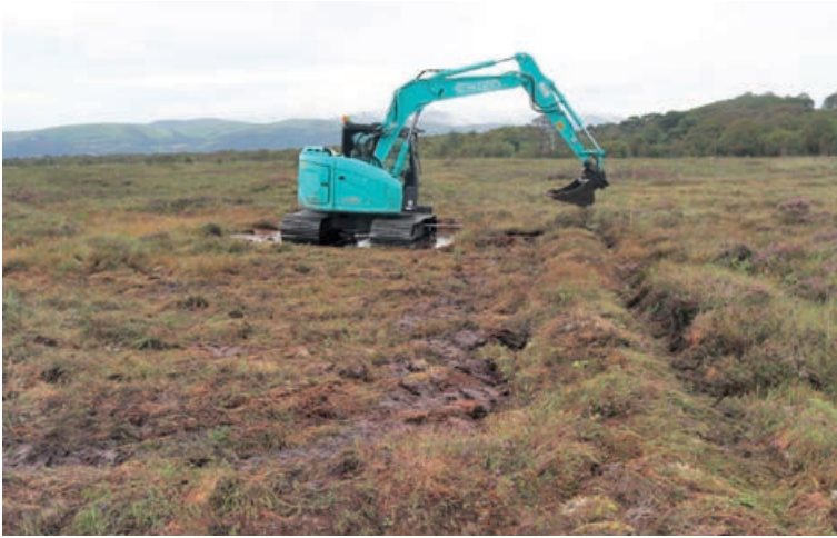
Gwaith byndio yn dechrau ar Gors Fochno ger y Borth. Gallwch weld y clawdd mawn isel (bynd) efo llystyfiant wedi ei gosod ar ei dop lawr ochr dde'r llun.
